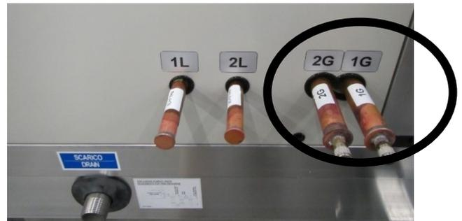
Pour protéger le panneau de l'unité WIZARDX spécial de la sortie des collecteurs de la batterie à expansion directe, l'unité est dotée d'une tôle de protection à retirer une fois les raccordements frigorifiques effectués.
