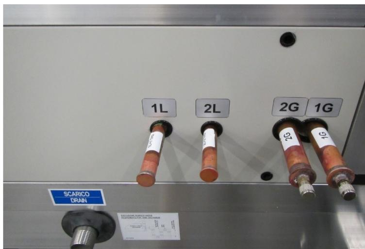
Quand les unités WIZARDX sont associées à des Mr. Slim d'une capacité différente, les étiquettes des collecteurs de la batterie ED indiquent également la dimension de la Mr. Slim à laquelle ils doivent être connectés.
