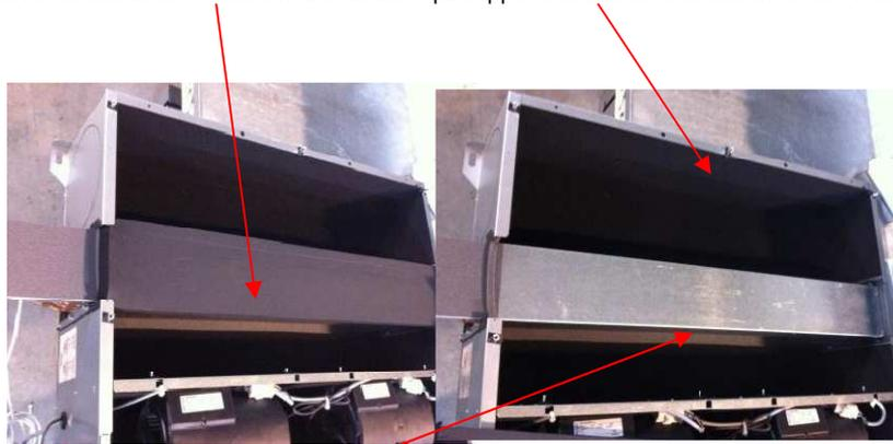
3. Dégager le bac en le tirant vers le bas (environ 20mm) pour le dégager de la batterie puis le sortir de l'unité par le dessous ou par le côté. Après désinfection remonter dans l'ordre inverse.
