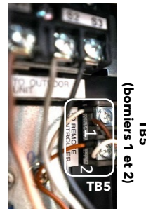
Monosplits 1 et 2 : Câblage entre PAR-41MAA et monosplit principal 1 + pontage monosplits 1-2 et monosplits 2-3
