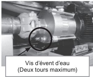
Pompe à eau (position de vis d'évent d'eau)
